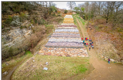
Photo aérienne du mur géologique (drone) A. Eme
